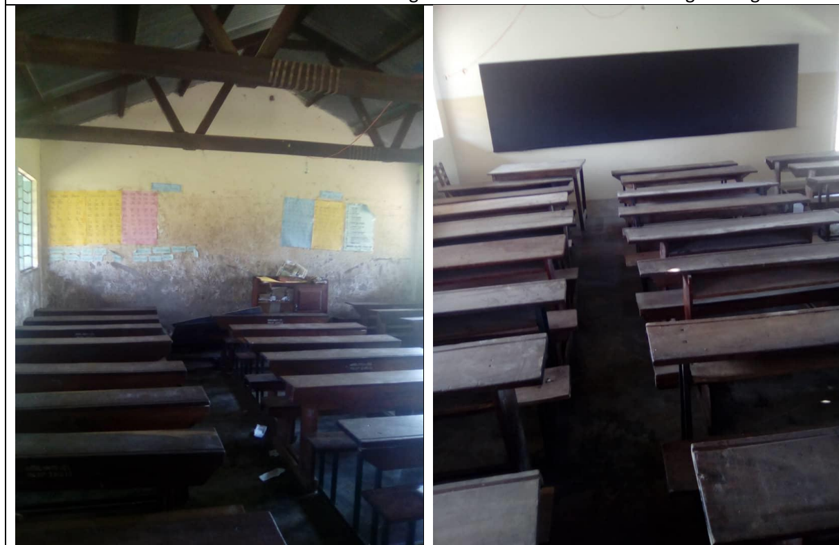
Bild 6 und Bild 7: Die Tafel wurden neu eingefasst und mit schwarzer Tafelspezialfarbe gestrichen, die Innenwände erhielten eine Grundierung und Lackfarbenanstrich.
