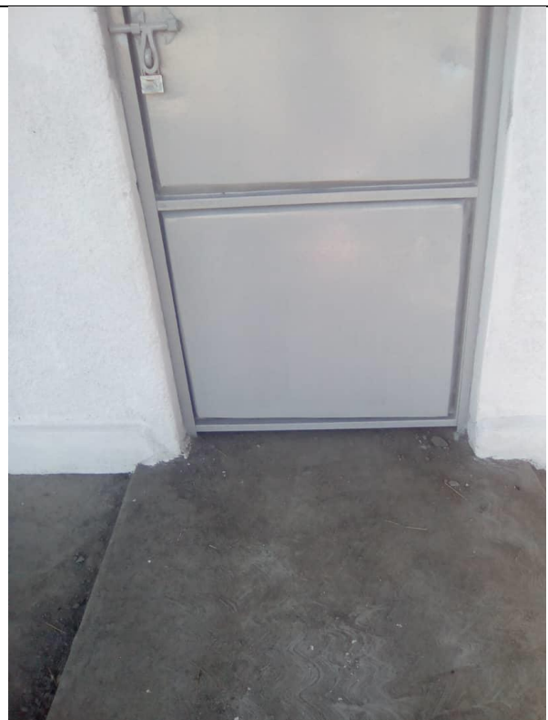
Bild 15: Details Reparatur der Türen zu den Klassenräumen
