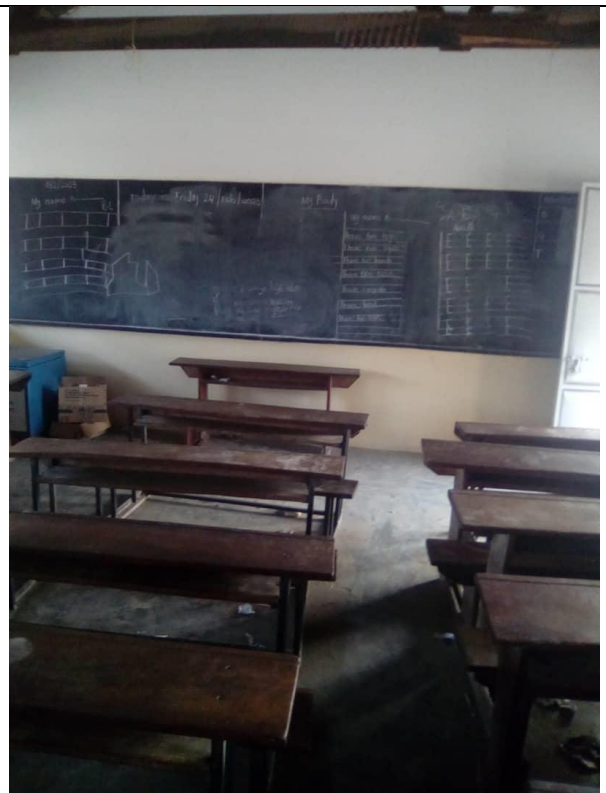
Bild 11: Innenansicht mit neu gestrichener und befestigter Tafel (Klassenraum P5)
