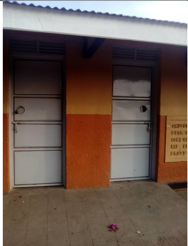
Bild 13: Instandgesetzte Tür von Klassenräumen P1 und P2
